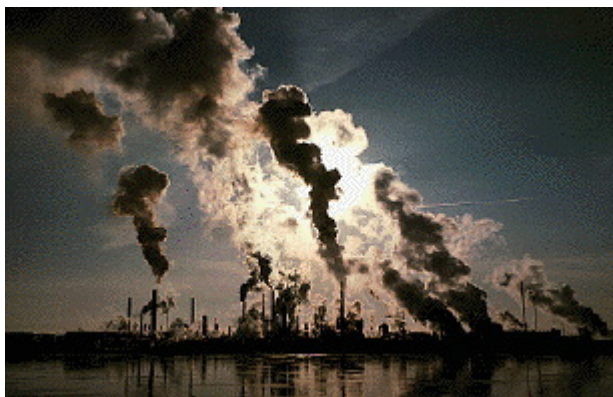
Slika 2. Prikaz termoelektrane u radu
