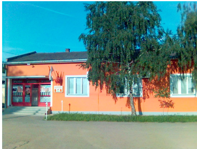
Slika 1.1. Upravna zgrada fabrike “Sloga” a.d.
